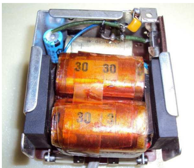
Il trasformatore ed i nuovi condensatori
